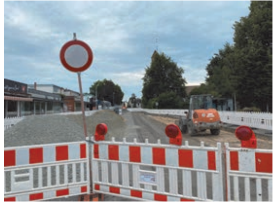
Umbau der Bushaltestellen
